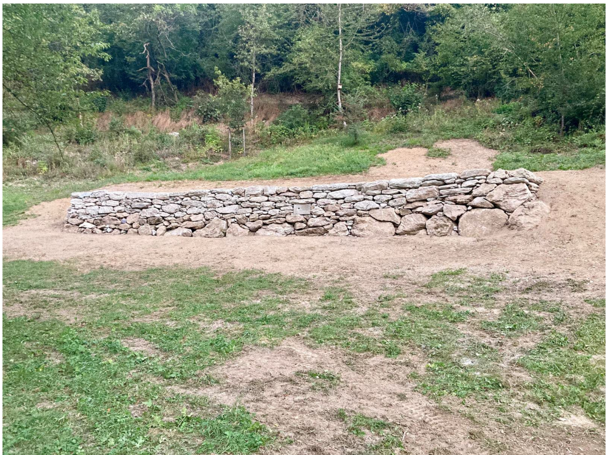
Abb.: 6: Trockensteinmauer Carnetg nach der Sanierung © Stiftung Platta Pussenta 2024
