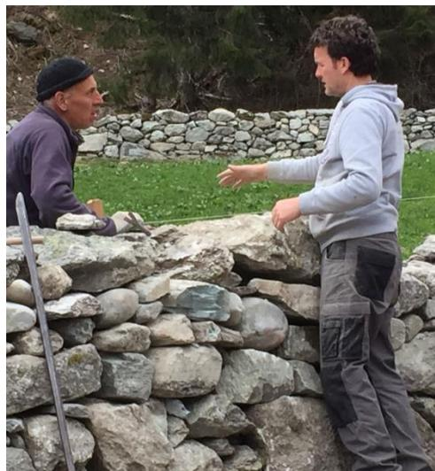
Trockenmauer. Arbeitseinsatz war wie am Tag zuvor jeweils 8,5 Stunden Einsatz. Die Leistung war ähnlich wie am Vortag ca. 10 Laufmeter Trockenmauer wurden neu errichtet.
