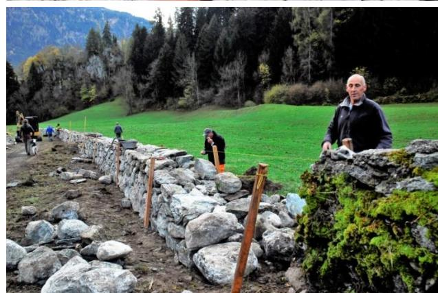
Abschliessend möchte ich erwähnen, dass wir in der gesamten Woche 43,5 Laufmeter freistehende Trockenmauer neu erstellt haben. In der Summe ergibt das bei einer durchschnittlichen Höhe von 1,2 Metern eine Gesamtfläche von 104,40 Quadratmeter Trockenmauer welche von Grund auf erneuert wurden. Berechnet man die gesamten Stunden, so kommen wir auf eine Gesamtarbeitszeit von 221 Stunden Einsatz aller Hilfskräfte zusammen. Der 5 Tonnen Bagger war 32 Stunden im Einsatz.
