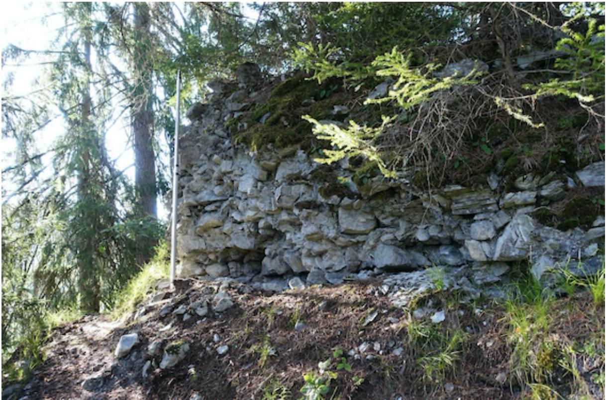
Abb. 6: Nordmauer M1 des Turms, Aussen. Schadstelle/ausgebrochene Mauerschale (Foto: ADG, 11.08.2020)
